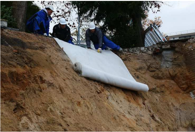
BVR 9000: Verlegung auf der zu sichernden Böschung
