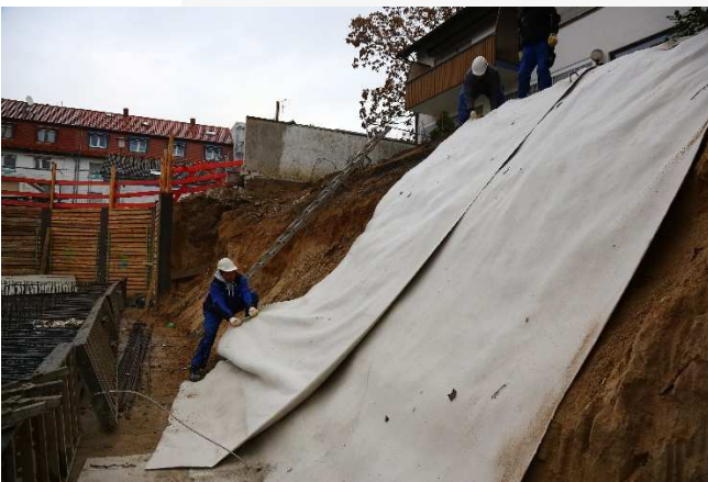
BVR 9000: leichte Verlegung, einfaches Korrigieren der Überlappung
