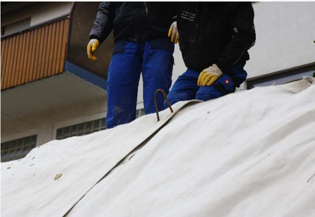
BVR 9000: Sicherung mit Erdnägeln
