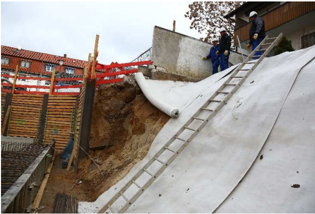
BVR 9000: flexible Anpassung an die vorhandene Geometrie
