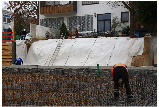
Baustellenansicht: die Böschung ist gegen Erosion gesichert
