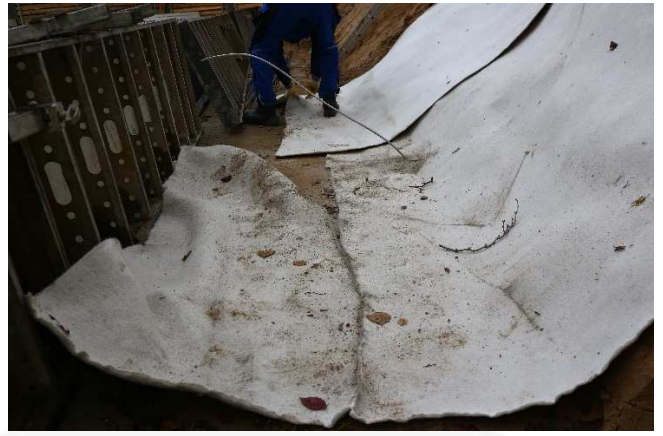
BVR 9000: unkompliziertes Schneiden mittels Cuttermesser
