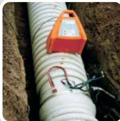
erdverlegte PP-Profilrohrleitung mit integrierter Elektromuffe
