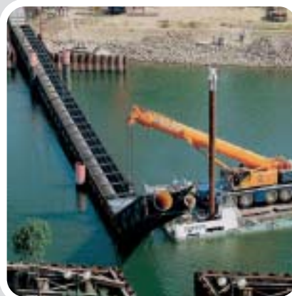
PKS-Kanalrohr DN 1400 und DN 800 in Stahlkassette
