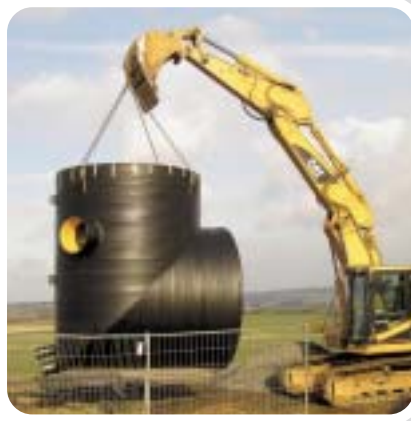
PKS-Stauraumkanal DN 3000 komplett vorkonfektioniert
