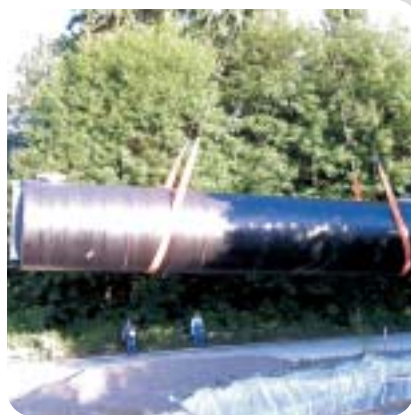
werkseitig komplettiertes Rückhaltebecken DN 3000
