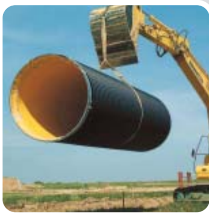
PKS-Kanalrohr DN 1800 mm, Neuverlegung
