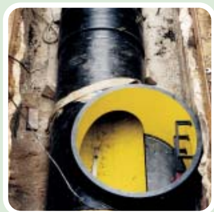
PKS-Rohrleitung DN 800 mit Tangentialschacht DN 1000 Rohrverbindung mit integrierter Elektroschweißmuffe
