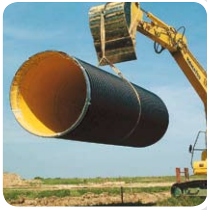
PKS-Kanalrohr DN 1800 mm, Neuerlegung
