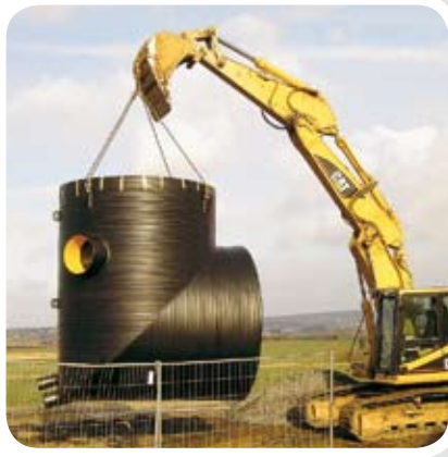
PKS-Stauraumkanal DN 3000 komplett vorkonfektioniert
