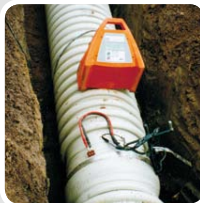
erdverlegte PP- Profilrohrleitung mit integrierter Elektromuffe
