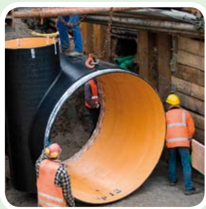
PKS-Rohrleitung DN 2300 mit Tangentialschacht DN 1000 Rohrverbindung mit integrierter Elektroschweißmuffe
