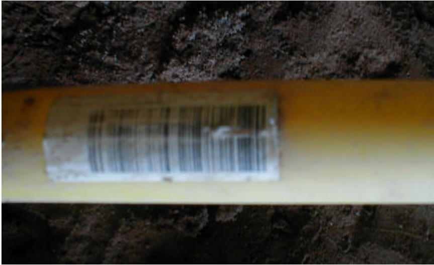
Bild 10: Etikett am Rohr nach grabenloser Verlegung
