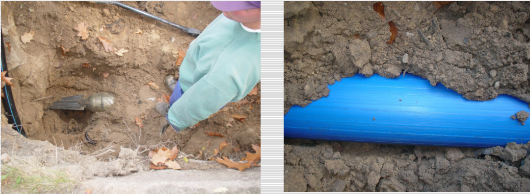
Abb. 2: Kontrollschachtung mit Berstkopf und mit nachfolgendem Rohr
