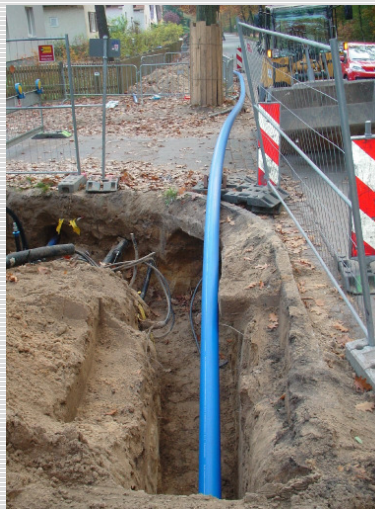
Abb. 1: Startgrube, vorbereiteter Rohrstrang "taucht ab"
