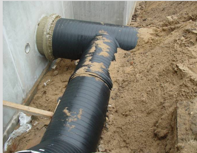
Abb. 4: T-Stück DN 1000/900 mit Flanschschluss, Sonderbaulänge nach Zeichnung
