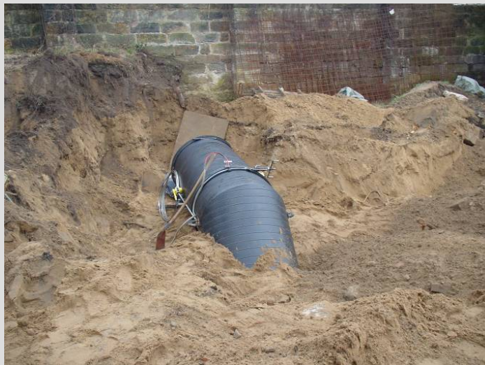
Abb. 2: Verschweißung PKS-Leitung DN 1000
