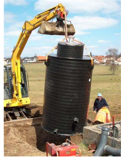
Bild 3 + Bild 4: Transport und Einbau des PE-Schachtes mit leichtem Gerät
