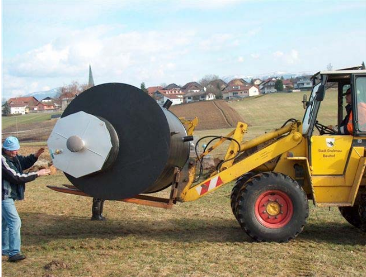
Bild 3 + Bild 4: Transport und Einbau des PE-Schachtes mit leichtem Gerät
