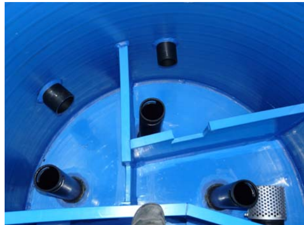
Bild 2: NACHHER → das Innenleben des neuen Schachtes aus PE
