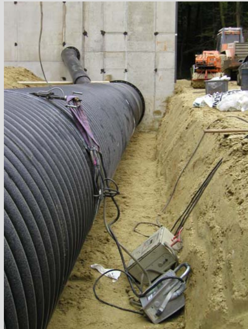
Schweißen PKS DN 1400 mit integrierter Heizwendel
