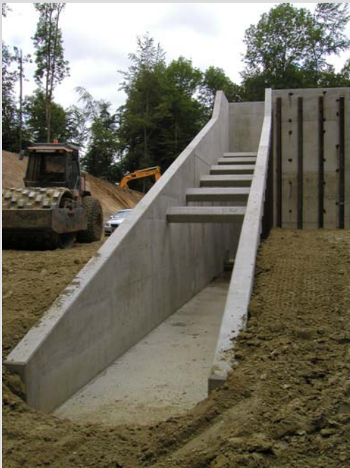
Drosselbauwerk während der Bauphase
