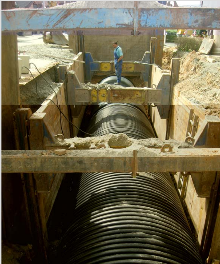
Abb. 3: Verlegter Stauraumkanal DN 2000
