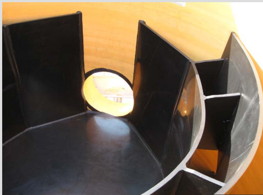
Abb. 3: Überlaufschwelle mit Entlastungsabfluss
