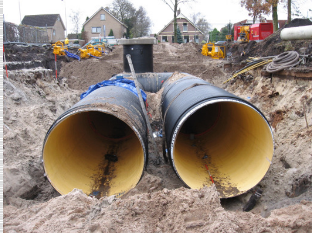
Abb. 2: Parallelleitung mit PKS-Rohr DN 2300
