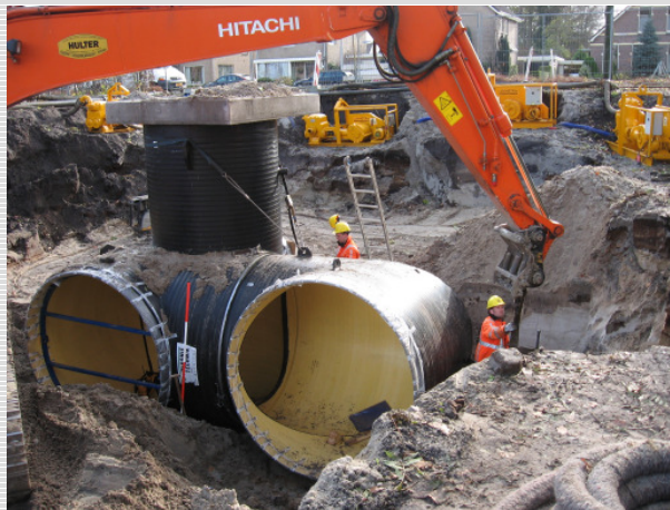
Abb: 1: Sonderbauwerk DN 2300 mit Pumpschacht DN 1800
