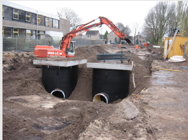
Abb. 3: PKS-Überlaufschächte DN2300
