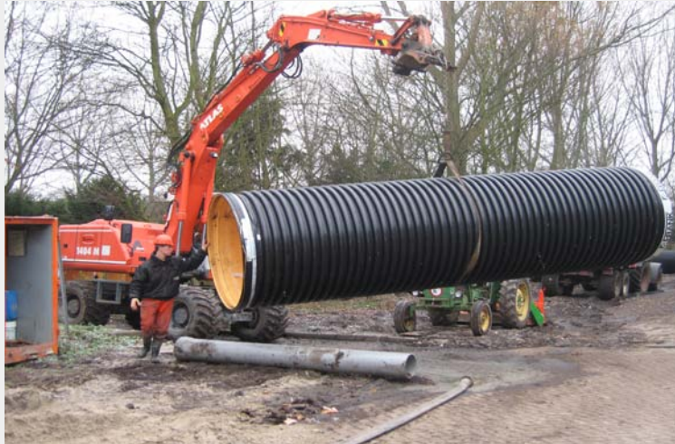
Abb. 2: Transport von Rohr DN1500 (6mtr Länge) zum Rohrgraben.
