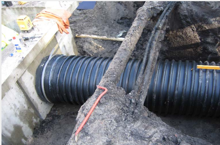
Abb. 1: Wandeinbindung an Betonschacht und 1. Rohr DN800 der Zulaufleitung.
