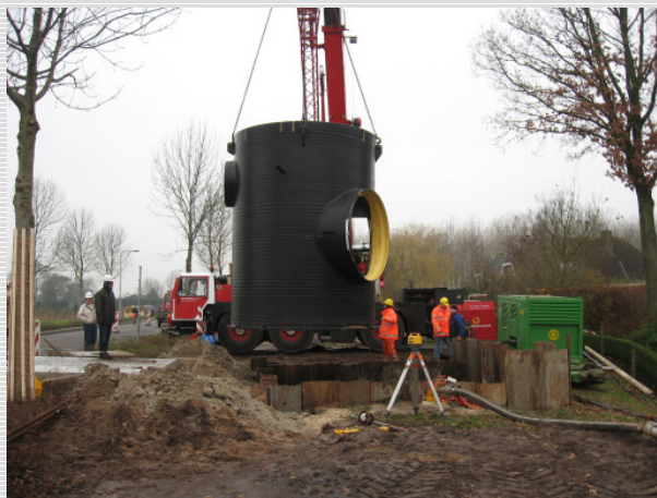
Abb. 3: Setzen des Überlauf- / Pumpschachtes DN 3000
