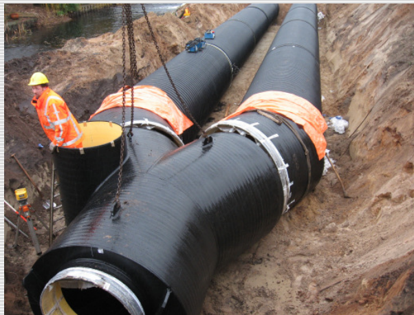
Abb. 4: Montage des Einlaufbauwerkes DN 1800 mit integriertem Inspektionsschacht DN 1000
