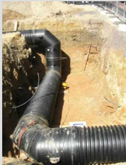
Abb. 2: Etagenbogen zum Höhenausgleich
