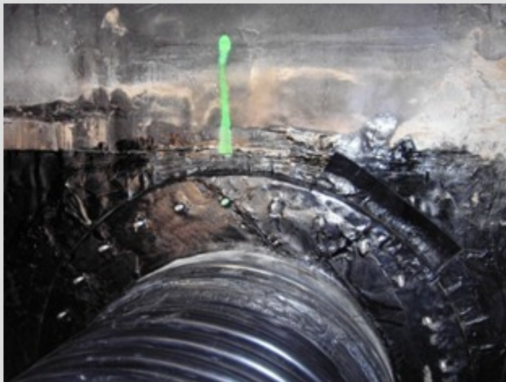
Abb. 4: Festflansch Bitumenabdichtung an vorhandene Wandabdichtung
