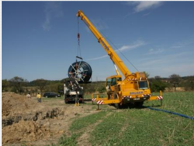
Abb. 1: Abladen einer Haspel mit SureFIT-Liner
