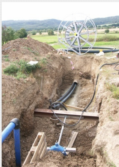
Abb. 3: SureFIT nach dem Einziehen ins Stahlrohr
