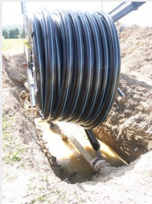
Abb. 2: Einziehen des SureFIT-Liners ins Altrohr
