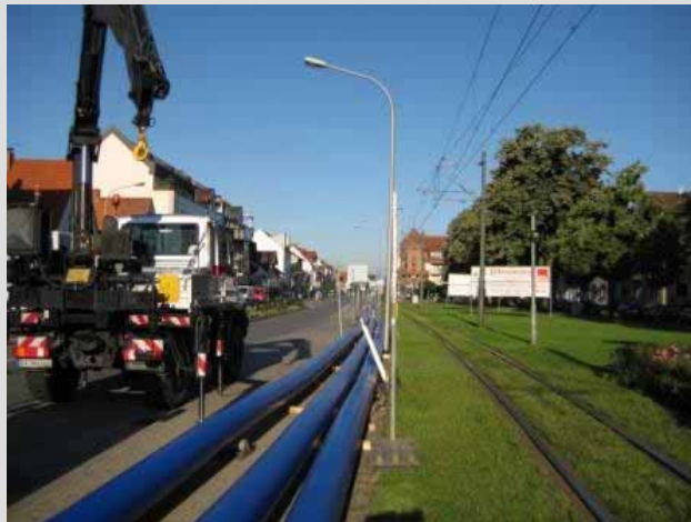
Abb. 1: Lagerung der da 315mm Sureline-Rohre mit Einhaltung des Mindestabstandes zur Straßenbahn
