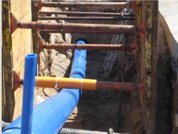
Abb. 2: Einziehvorgang beim Relining-Verfahren
