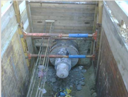
Abb. 4: Die bereits aufgeschwämmte d 450mm PE 100 Rohrleitung
