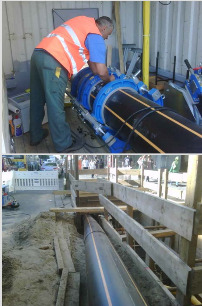
Abb. 1: Die Rohre wurden stumpfgeschweißt und eingezogen
