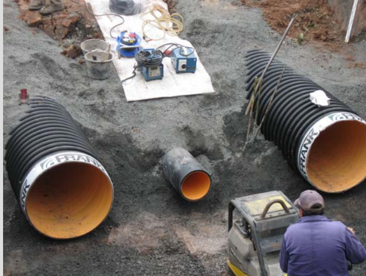
Abb. 3: Ansicht mit Schweißmaschine
