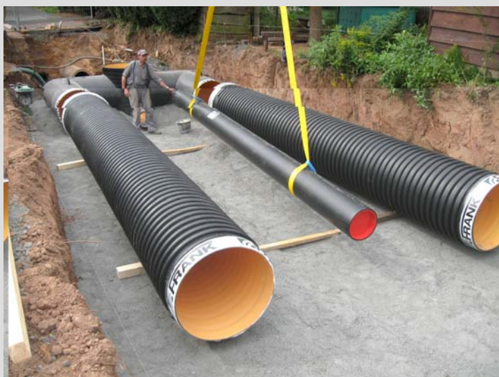
Abb2.: 3-in-1-Verlegung
