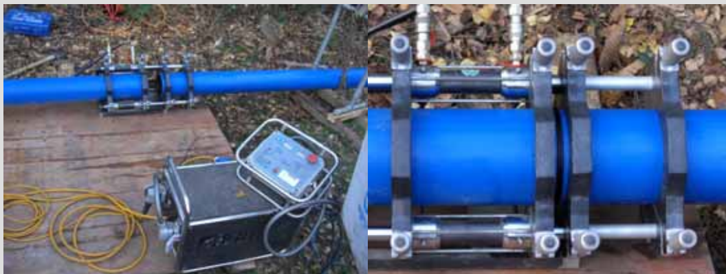
Abb. 2: Die Stumpfschweißmaschine Frank 160 NC im Einsatz bei den Schweißern der Stadtwerke Bühl
