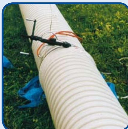
Angeformte Elektroschweißmuffe
