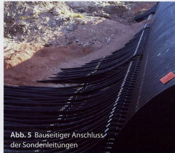
Abb. 5 Bauseitiger Anschluss der Sondenleitungen
