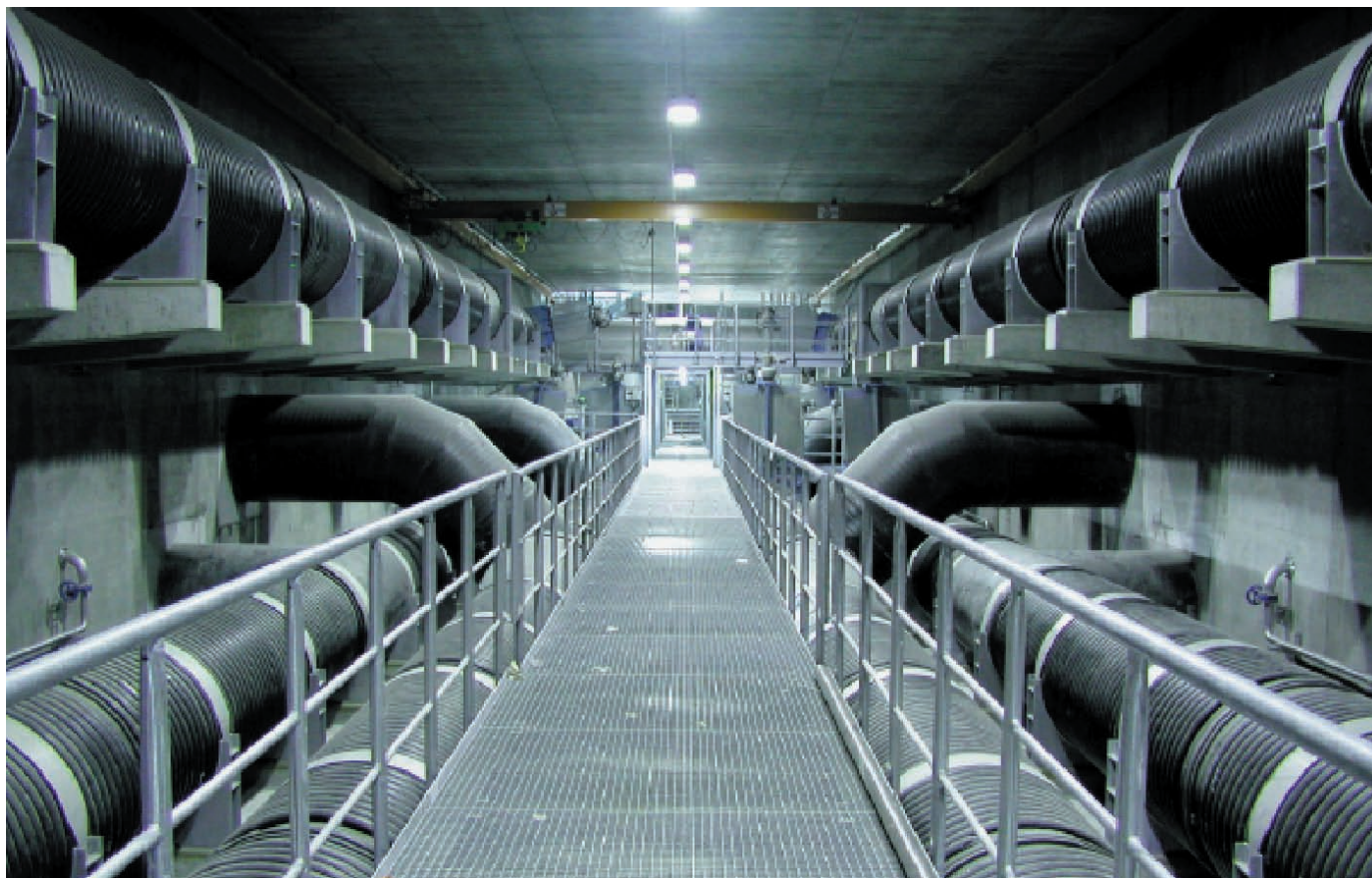
Bild 1: Überblick über den Installationsgang mit verlegten Leitungen DN 100, DN 1200, DN 1400
