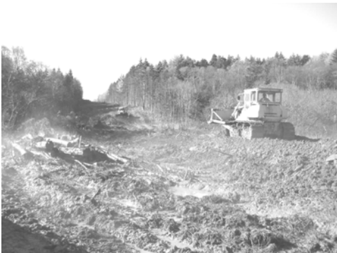
Bild 2 - Vorbereitung der Rohrtrasse in unberührter Natur
