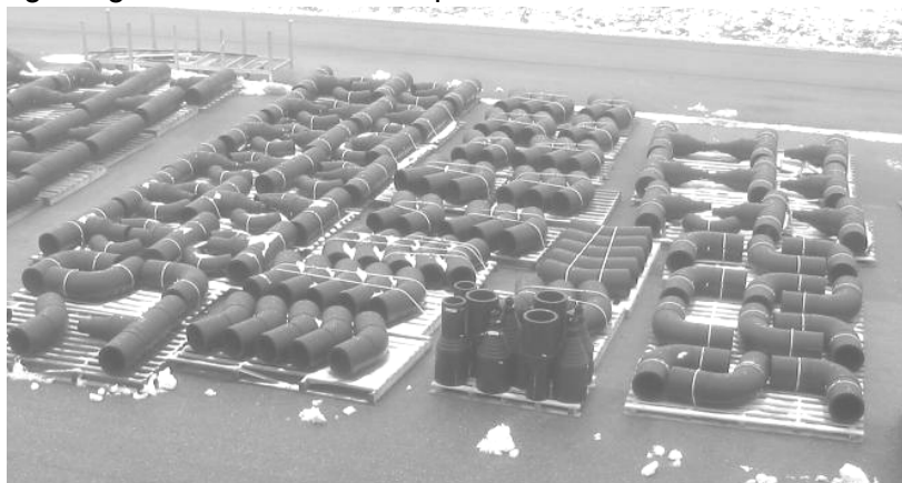
Bild 10 - vorkonfektionierte Sonderformteile für den Einbau in den Rohrleitungsstrang
