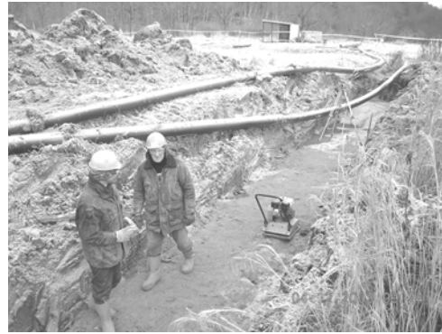
Bild 5 - Vorbereitung der Sandbettung vor dem Einbringen des Rohrstranges
