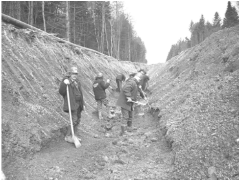
Bild 4 - manuelle Nachbesserung des Rohrgrabens
