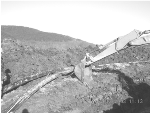
Bild 8 - Einbringen des Rohrstranges in den Rohrgraben
