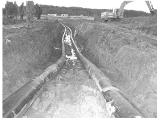
Bild 9 - verlegter und geprüfter Rohrstrang im Graben
