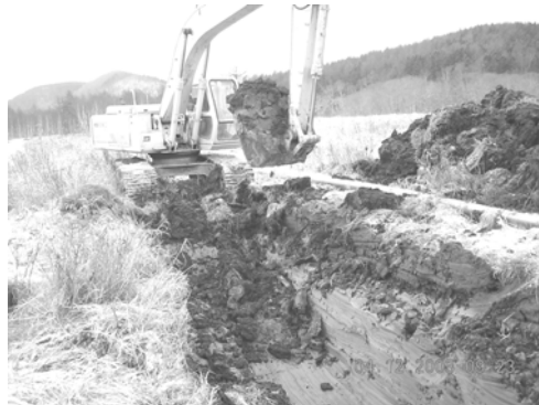
Bild 3 - Aushub des Rohrgrabens bis zu der vorgegebenen Verlegetiefe des Rohres
