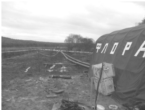
Bild 6 - eingerichteter Schweißplatz mit Schweißzelt
