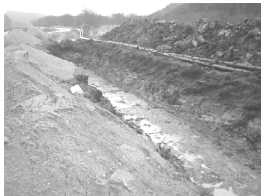
Bild 7 - Transport des Rohrstranges zum Rohrgraben
