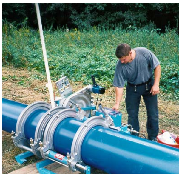
Bild 2: Rohrverlegung mit PE 100 heute
