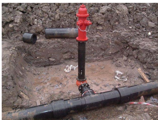
Bild 17: Übergangsformteil PE-Guss
