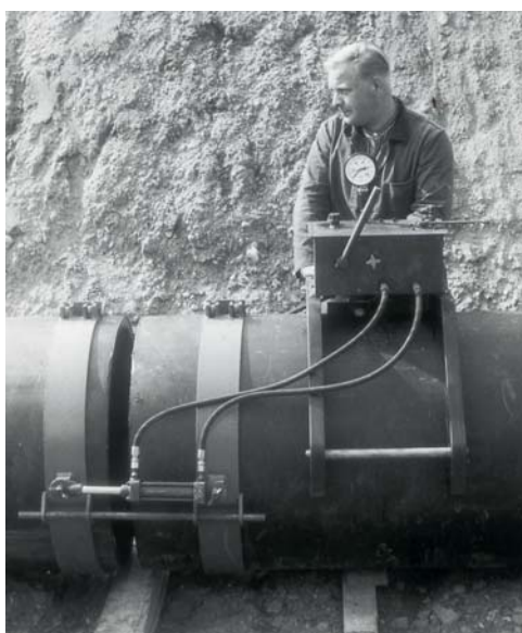
Bild 1: Rohrverlegung mit PE-HD in den 60er Jahren
