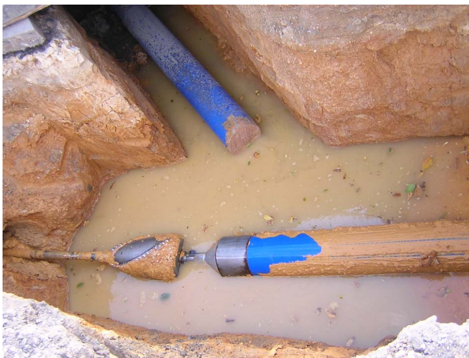
Bild 32: Spülbohren mit einem PE-100-Rohr mit besonderen Schutzzeigenschaften
