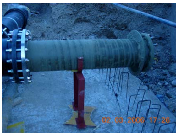
Bild 16: Übergangsformteil PE-Stahl
