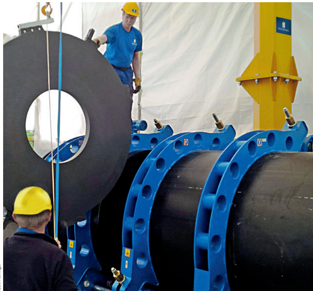
Abb. 4 – Die Herstellung der Schweißverbindungen erfolgte im Heizelement-Stumpfschweißverfahren.
