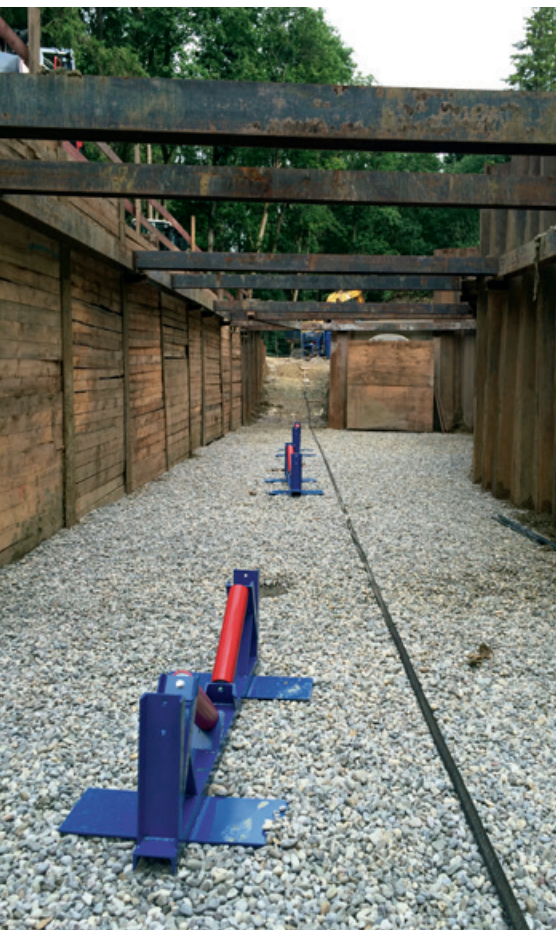
Abb. 3 – Verbaute Baugrube am Zielschacht
