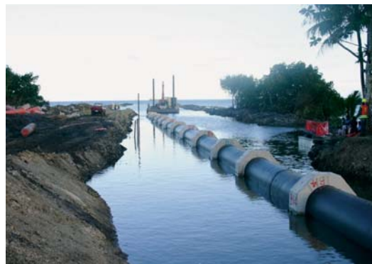
Bild 16: Fertig gestellte Seeauslaufleitung
