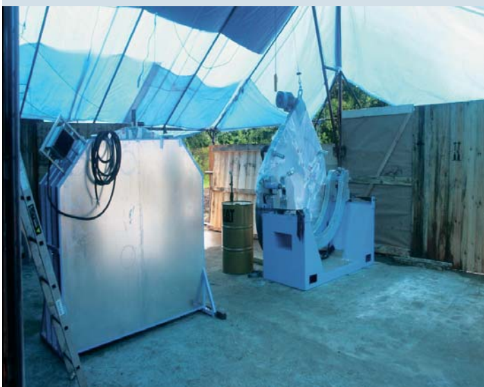
Bild 11: Überdachter und befestigter Schweißplatz Fig. 11: Roofed and stabilised welding location
