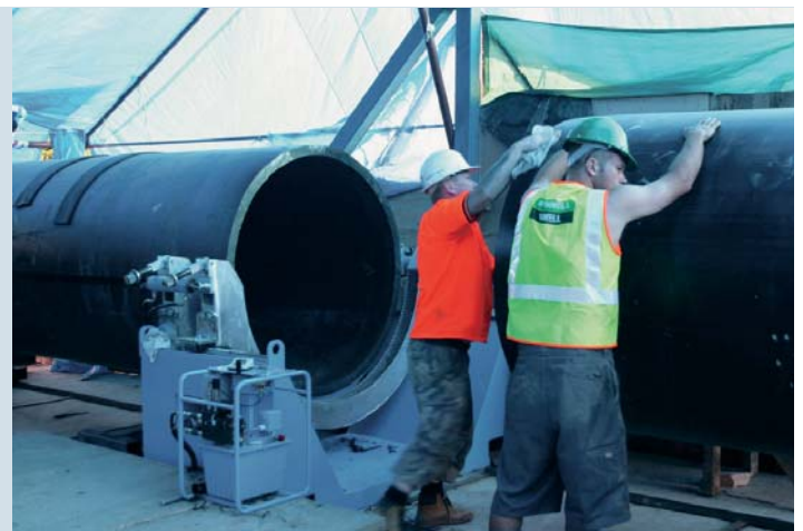
Bild 12: Einlegen der Rohre in die Schweißmaschine Fig. 12: Insertion of the pipes into the welding machine
