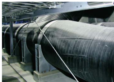
Bild 27: Unterbau-konstruktion für ein Sonderbauteil (T-Stück DN 1.400 mit Reduktion auf DN 1.200)
