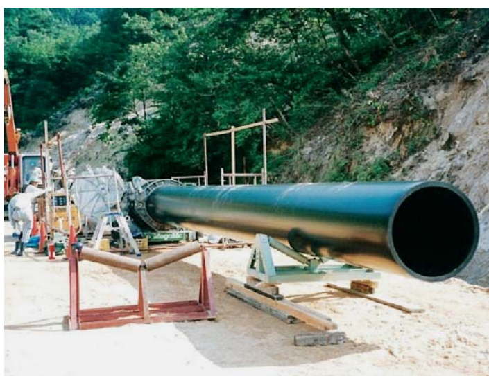
Bild 7: Verlegung von Großrohren Fig. 7: Laying of large-diameter pipes
