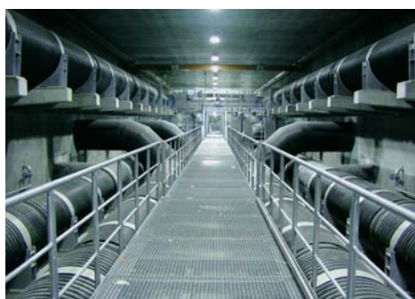
Bild 28: Überblick in den Installationsgang mit den verlegten Leitungen DN 1.400, DN 1.200 und DN 1.000
