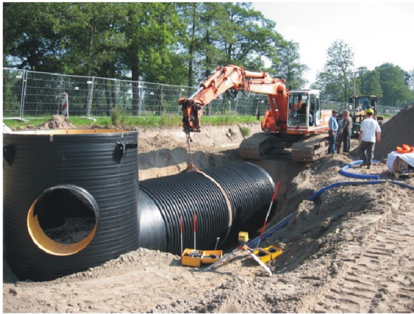
Quelle: Baustellenfoto FRANK GmbH
