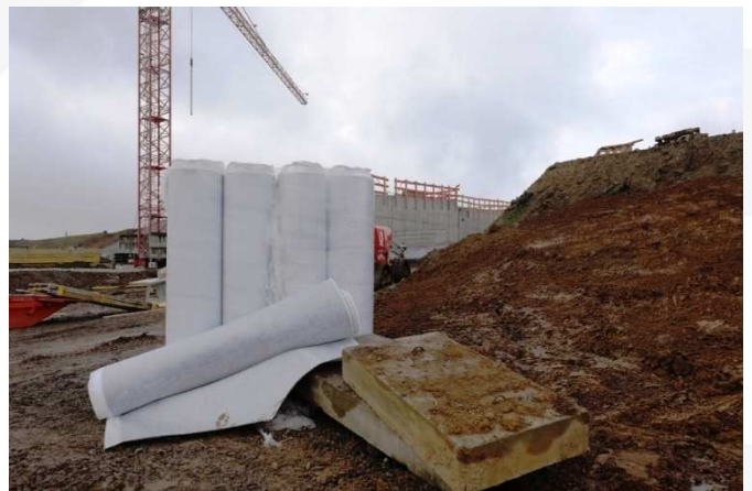
Baustellenansicht: Drainagematte FRANK FDV-2F angeliefert zum Einbau
