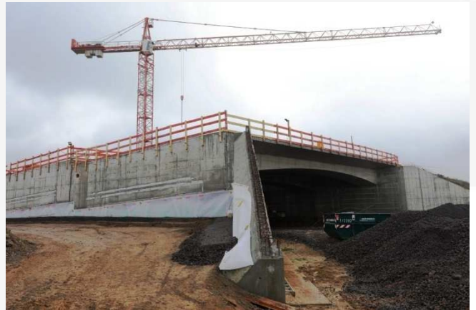
Baustellenansicht: die Bauwerkshinterfüllung wird lagenweise eingebaut und mit leichtem bis mittelschwerem Gerät verdichtet
