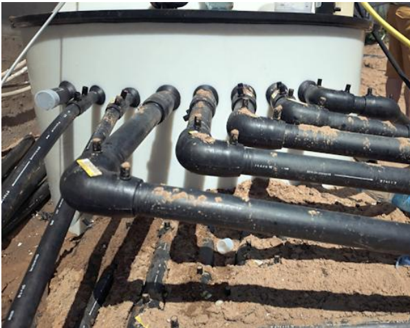
Abbildung: Baustelle Dreieichstraße in Mörfelden mit THERMTANK. © Frank GmbH
