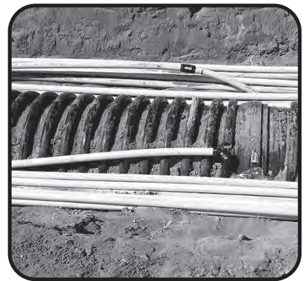
Einfacher Anschluss der Anbindeleitungen mit Heizwendelschweißmuffe
