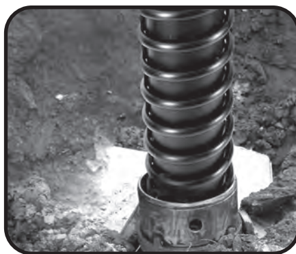
Einbringen des VTP® in das Bohrloch mit Hohlschneckenbohrer
