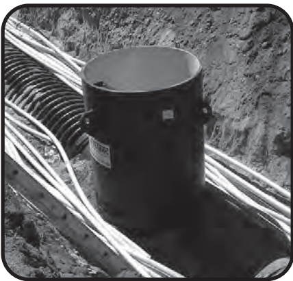
Parallele Verlegung der Anbindeleitungen im Bereich des Einstiegschachtes
