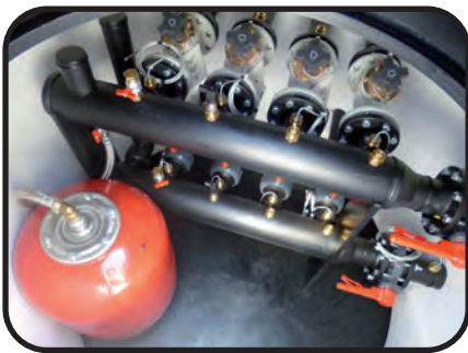
Übergeordneter Haupt-Verteilerschacht
