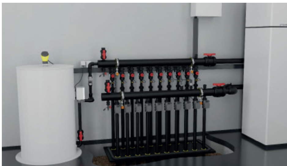
Abb.1 PE-Soleverteiler mit Nachspeisung
