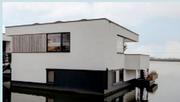
2017 - Schwimmendes Wohngebäude. 4 St. WET Typ 2, Woerden, Niederlande
