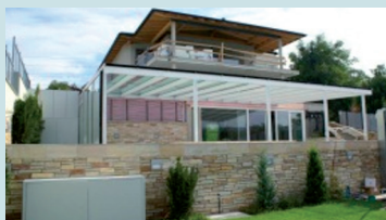
2017 - Wohnhaus mit Wfl. ca.400 m 2 + Schwimmbad. 6 St. WET Typ 2, Wörthersee, Österreich
