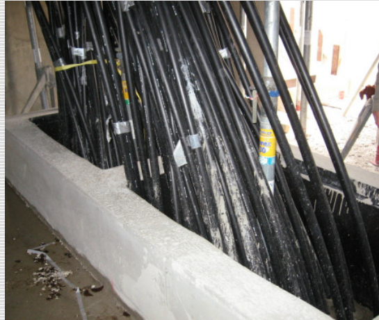
Picture 3+4: Casing for the insertion of the pipelines Schalung für die Einführung der
