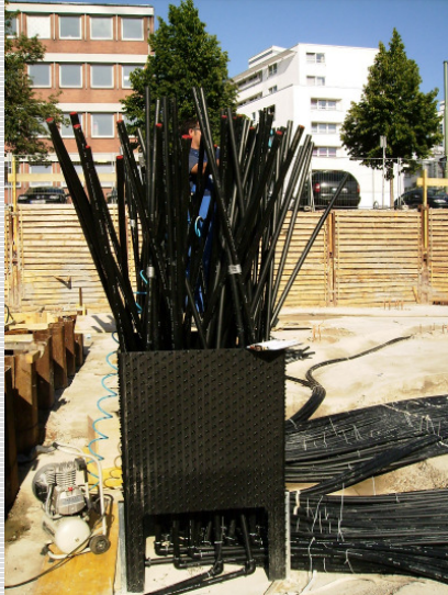
Picture 3+4: Casing for the insertion of the pipelines Schalung für die Einführung der
