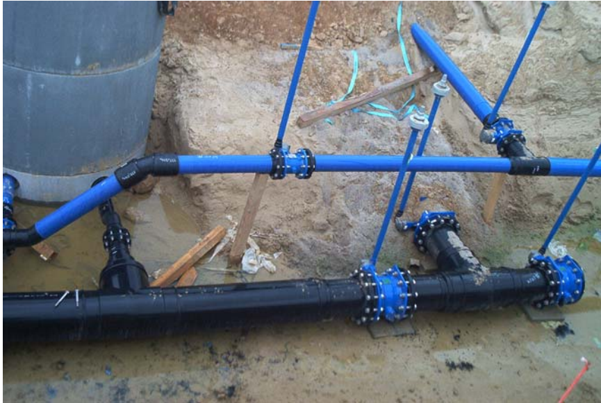
Bild 9: Einbindung von Armaturen in die Feuerlösch- und Trinkwasserleitung
