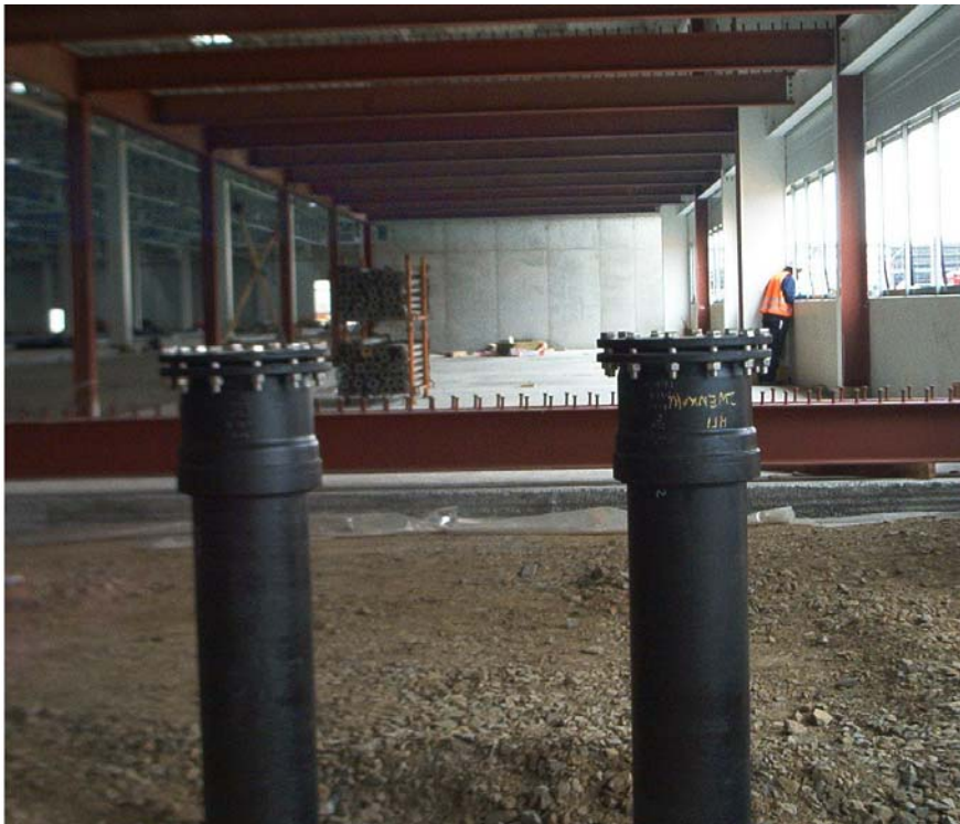
Bild 8: Vorbereitete Anbindung an die Sprinklerunterzentrale
