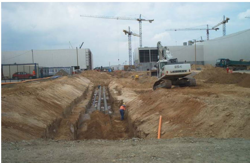
Bild 6: Parallele Anschlussleitung an eine Sprinklerunterzentrale
