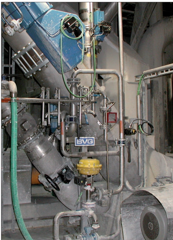
Bild 9: Kalkmilch-Regelventil DN 65 in der Papierindustrie
