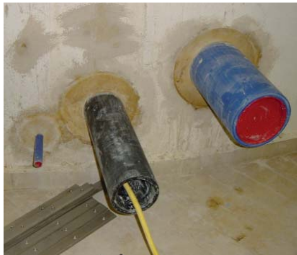
Bild 6. Tiefpunktleckagerohrleitung da 32 mm, unter dem Pumpensumpf eingebracht.
