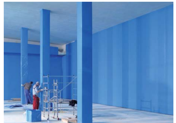
Bild 4. Rechtecksäule – mittels Heizelement-Schwenkbiegeschweißen gemäß DVS 2207-14.
