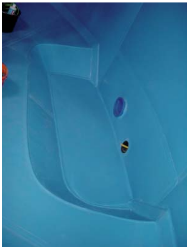
Bild 6. Tiefpunktleckagerohrleitung da 32 mm, unter dem Pumpensumpf eingebracht.
