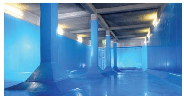
Bild 5. Statisch notwendige Voute in einem Rechteckbehälter.
