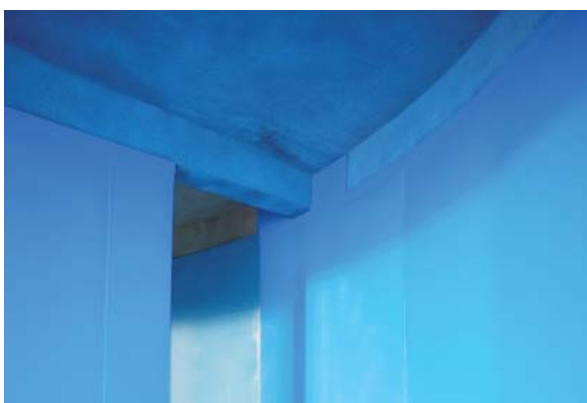
Bild 7. Oberer Randabschluss, in PE ausgeführt.
