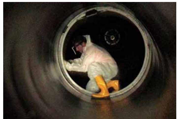
Bild 3: Herstellen des Rohrstranges (Anschweißen des Zugkopfes)
