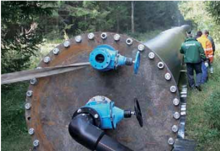
Bild 4: Geschweißter Inliner mit Anschluss für die Druckprüfung (2007)
