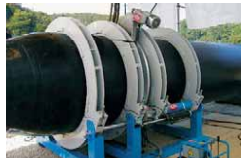
Bild 2: Herstellen des Rohrstranges (Anschweißen des Zugkopfes)
