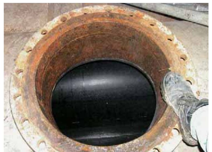
Bild 6: Lüftungsdom DN 600 aus Stahl mit durchgezogenem PE-Liner
