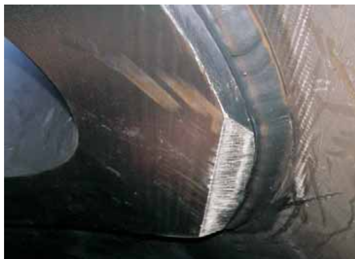
Bild 14: Fertige Kehlnahtverbindung
