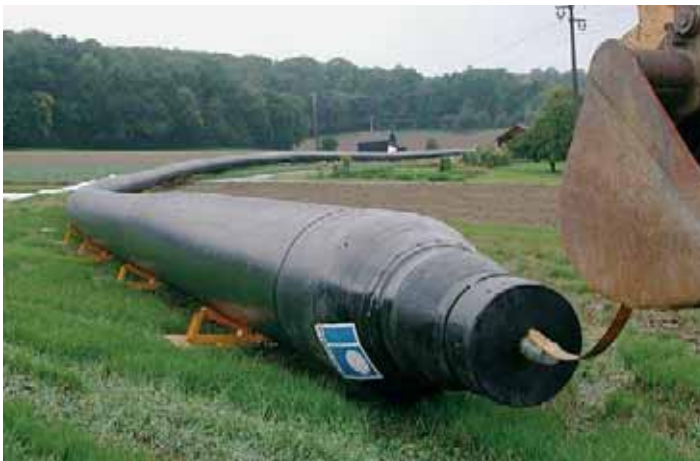
Bild 5: Vorgefertigter Rohrstrang im Krümmungsradius der Leitung (2006)
