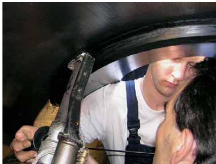
Bild 13: Einschweißen des Lüftungsstutzens mittels Warmgasextrusionsschweißen
