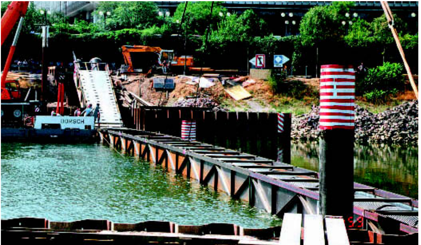
EINSCHWIMMEN NACH KURZER MONTAGEZEIT: Neckardüker beim Absenken
