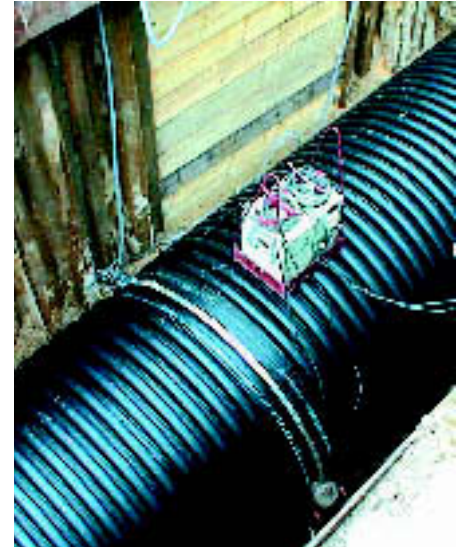
ZUGFESTE ROHRVERBINDUNG: Bild 8 Herstellung einer Schweißverbindung bei PKS-Rohren der FRANK GmbH
