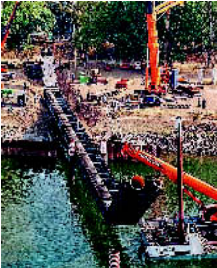
EINFACHES HANDLING SPART KOSTEN: Neckardüker in der Gesamtansicht Bild 6
