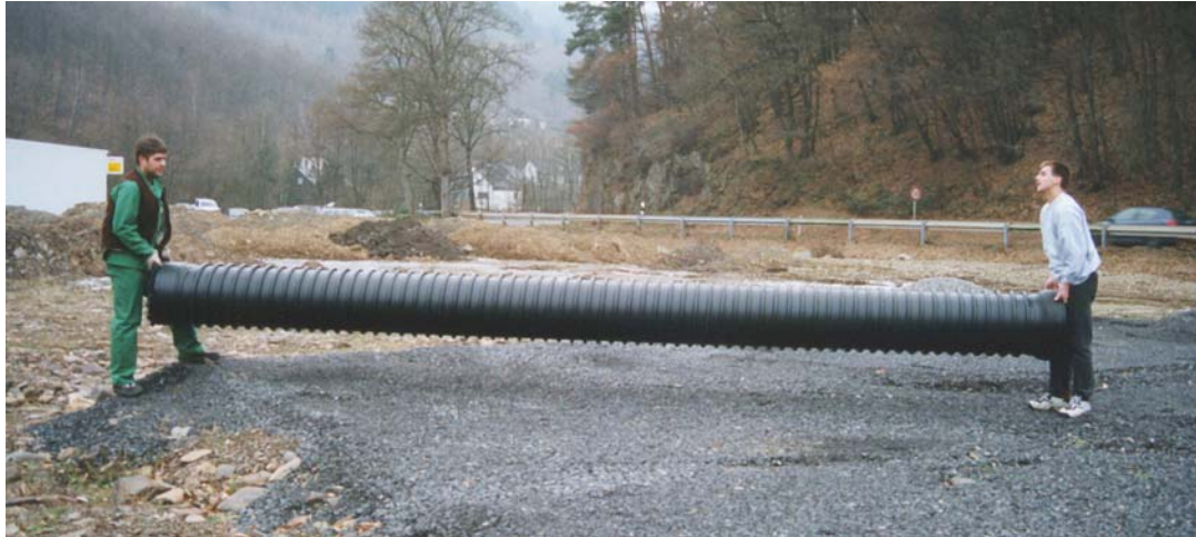
Bild 11: Handling von PKS-Rohren
