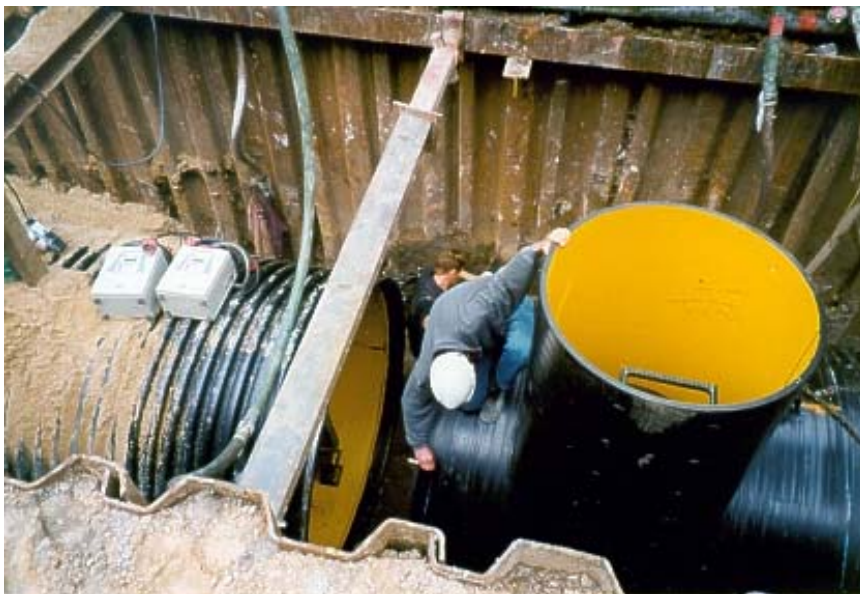
Bild 12: PKS-Rohr DN 2000 an der Baustelle
