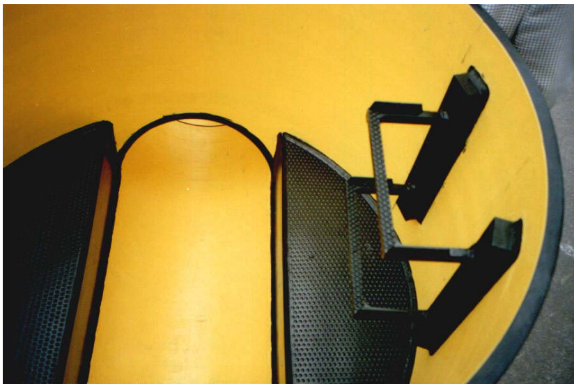
Bild 10: PKS-Schacht mit heller Innenwand
