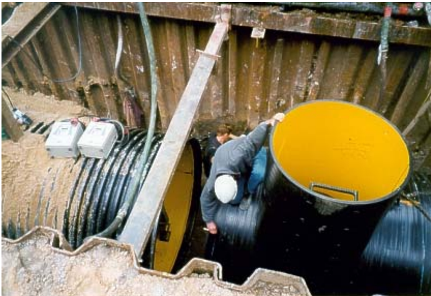
Bild 13: PKS-Rohr DN 2000 an der Baustelle
