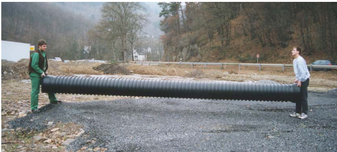
Bild 11: Handling von PKS-Rohren
