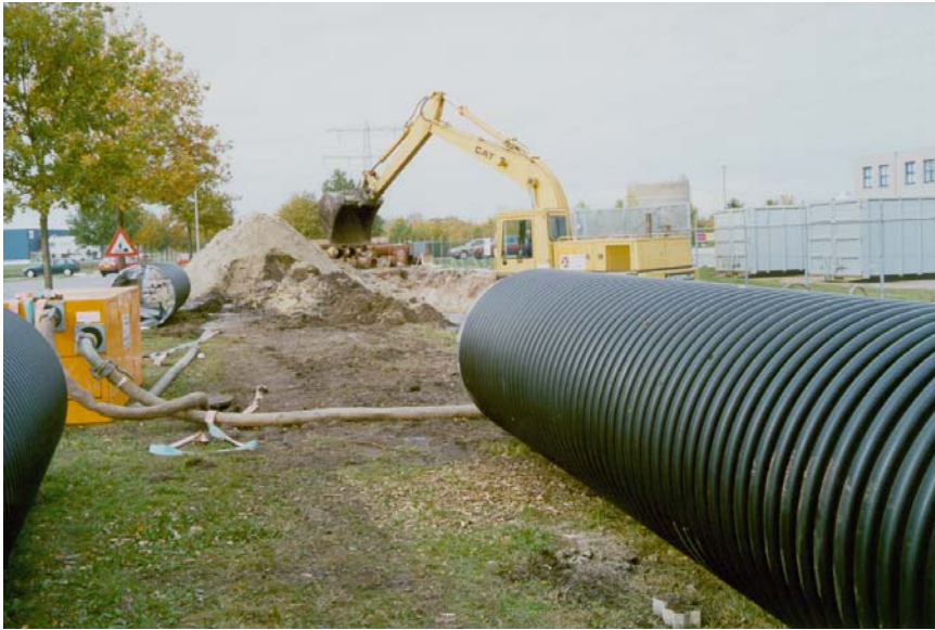
Bild 12: PKS-Rohr DN 1200 an der Baustelle
