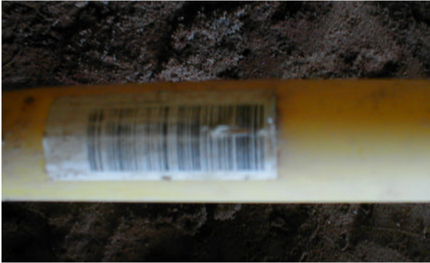
Bild 10: Etikett am Rohr nach grabenloser Verlegung
