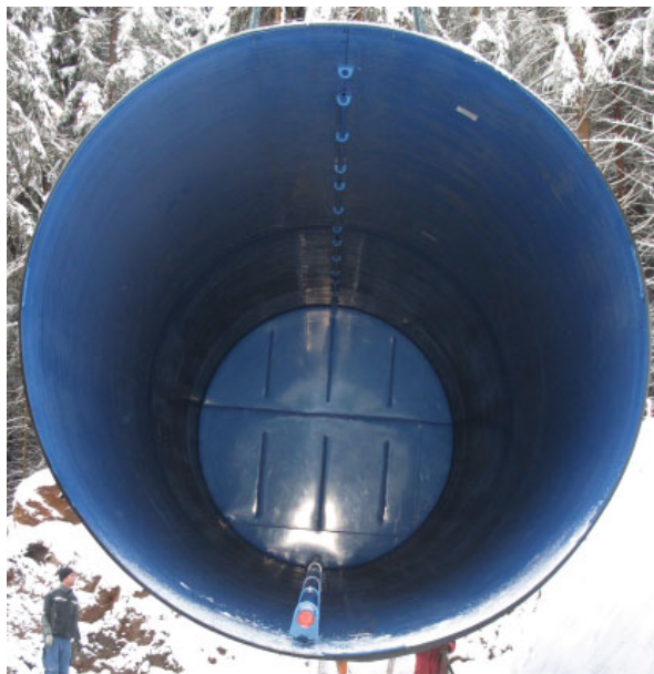
Bild 4. Teilsegment der PE 100 Wasserkammer.
