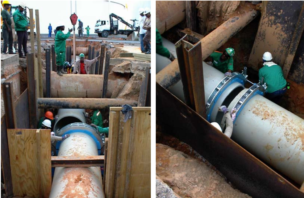
Abbildung 15: Stumpfschweißarbeiten im Graben auf Trinidad
