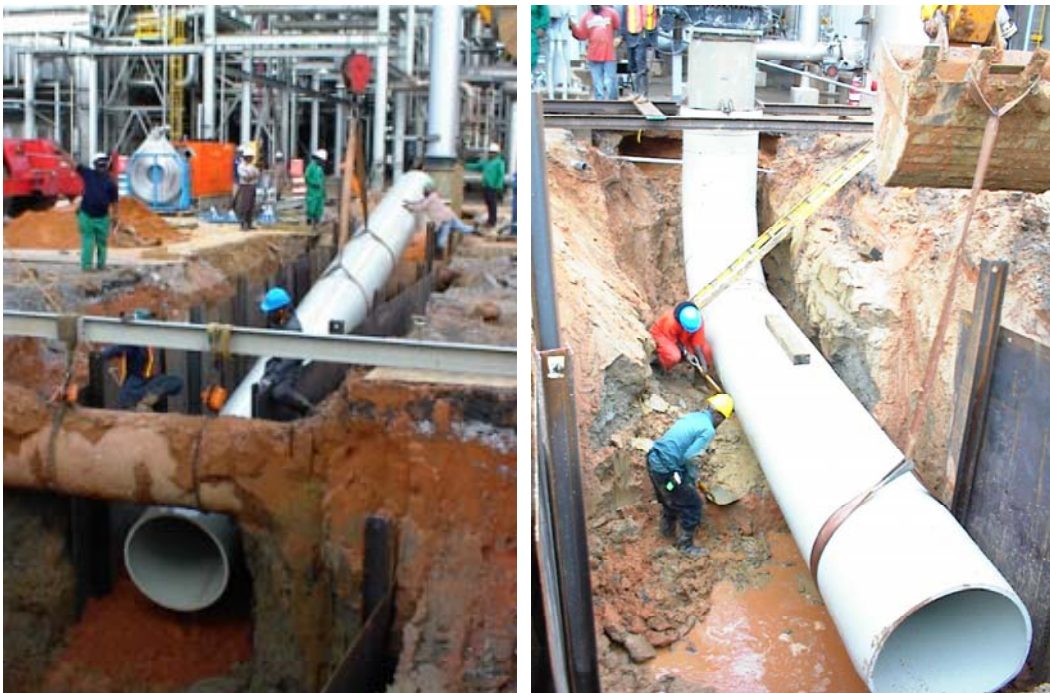
Abbildung 14: Installation der erdverlegten Polypropylen-Rohrleitung d 1050 mm
