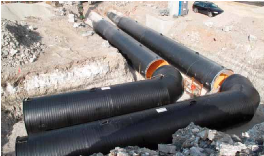
PKS-Secutec-Rohre DN 2000 mit Bogen 90° beim Einbau
