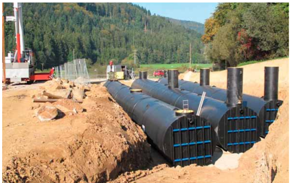
Die 3 Speicher mit Einstiegsdome vor dem Verfüllen der Baugrube
