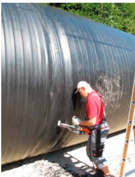
Schweißen außen und innen (Wärmegasextrusionsschweißung)
