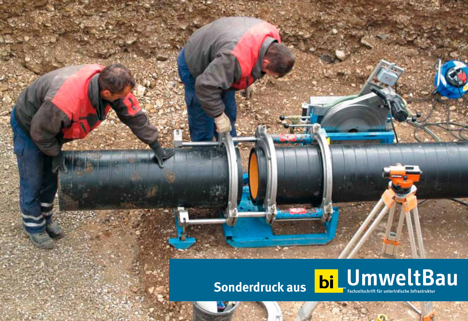
Heizelementstumpfschweißung der PKS-Secutec-Rohre DN 300
