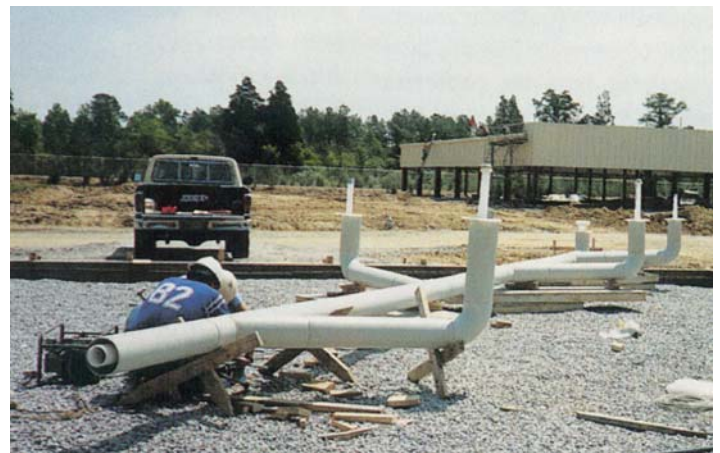
Bild 7: Kaskadenschweißung
