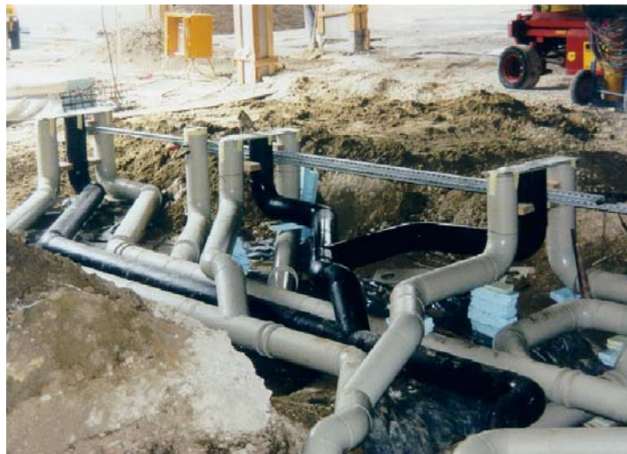
Bild 1: Doppelrohrsysteme aus PE und PP
