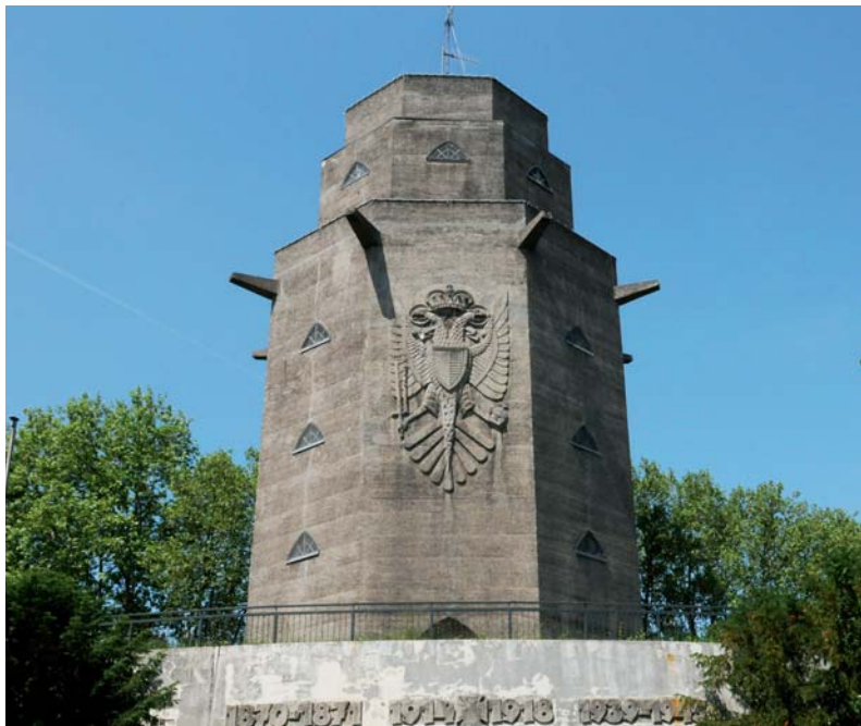
Hochbehälter Wartturm Außenansicht.
