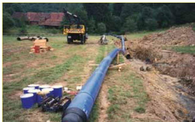
Bild 6: Sanierung einer Gussfernwasserleitung mit PE 100-Rohren, da 400 mm (Mainova Frankfurt am Main)
