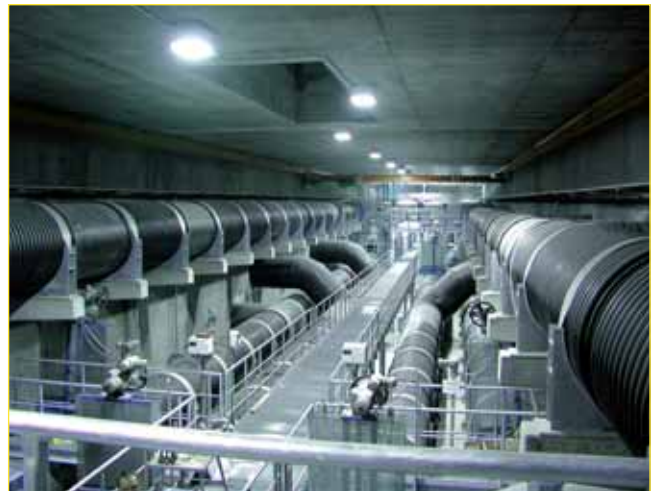
Bild 18: Druckleitungen DN 1400 – 1 bar aus PE 100 mit integrierter E-Muffe geschweißt (Kläranlage Ulm)
