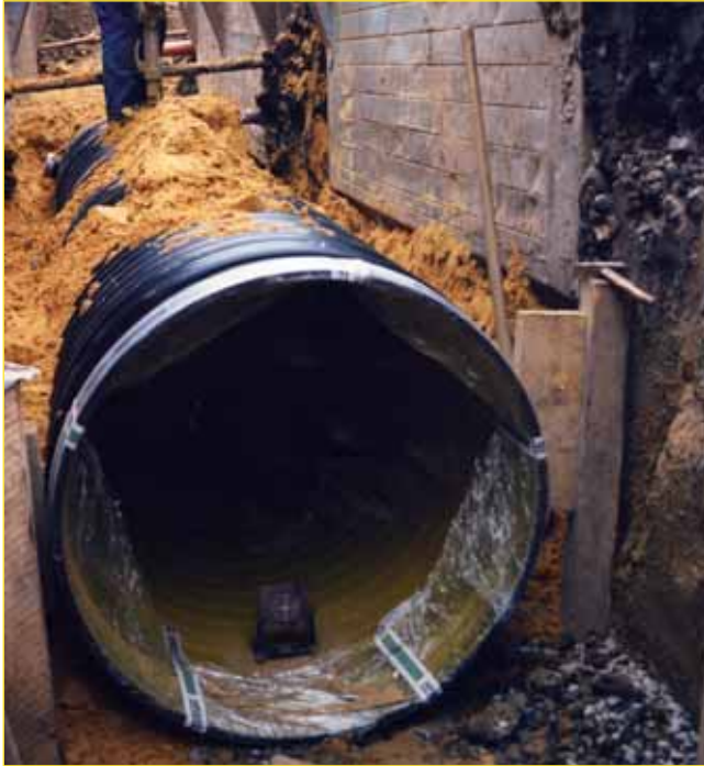
Bild 15: Großrohrverlegung im verbauten Graben
