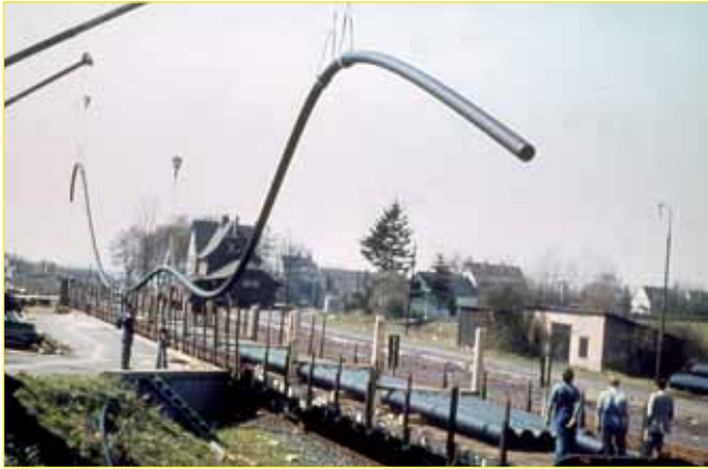
Bild 12: 100 m lange Rohre, DN 300, bei der Verladung auf Waggons
