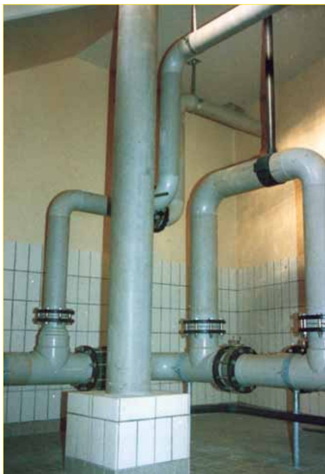
Bild 5: Verrohrung eines Trinkwasserhochbehälters aus PP
