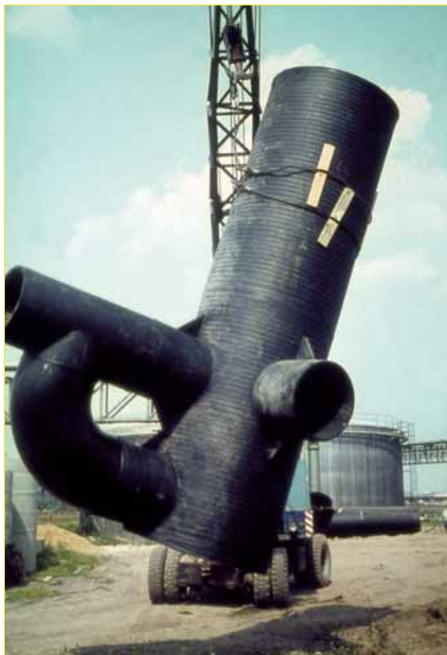
Bild 1: In Schweißkonstruktion aus PEHD-Wickelrohr hergestellter Absturzschaft für die Höchst AG Anfang der 70er Jahre
