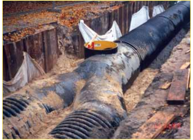
Bild 17: Beispiel Hosenstück mit integriertem Tangentialschacht (Hanse Wasser GmbH Bremen)
