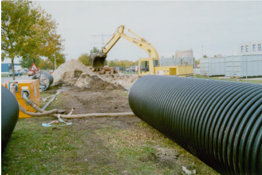
Bild 10: PKS-Rohr DN 1200 an der Baustelle
