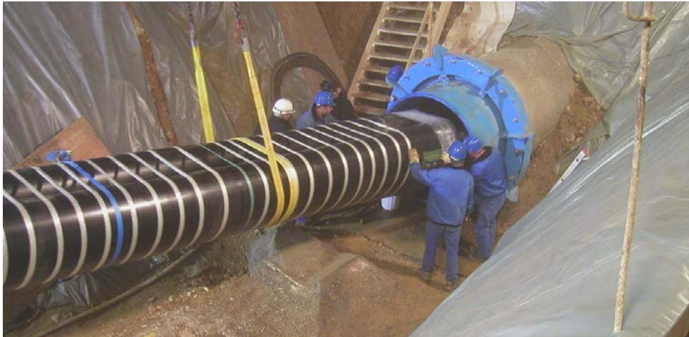
Bild 12: Einziehen des Liners mittels hydraulischer Winde
