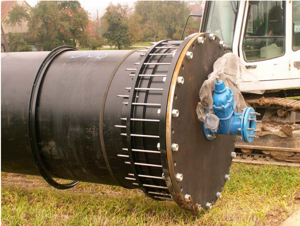
Bild 7: Geschweißter Inliner mit Anschluss für die Druckprüfung
