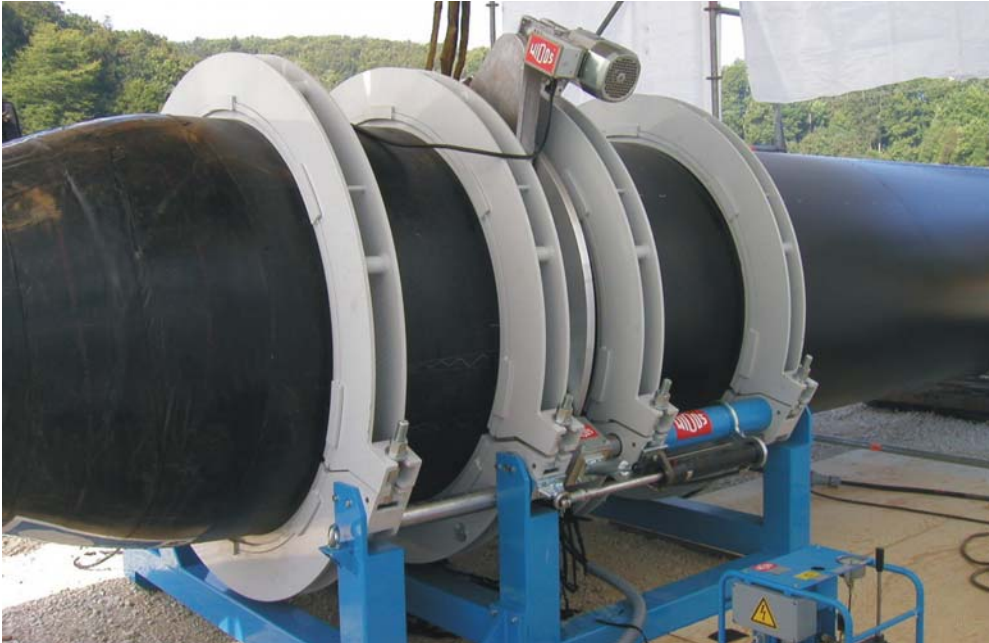
Bild 5: Herstellen des Rohrstranges (Anschweißen des Zugkopfes)
