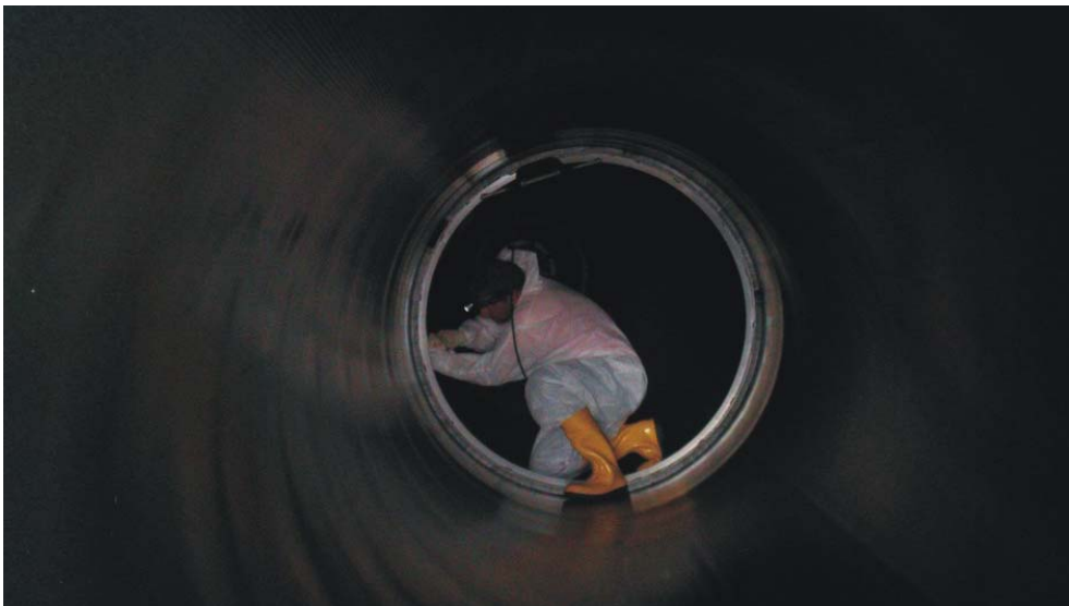
Bild 6: Entfernung des Innenwulstes mit keimfreier Ausrüstung
