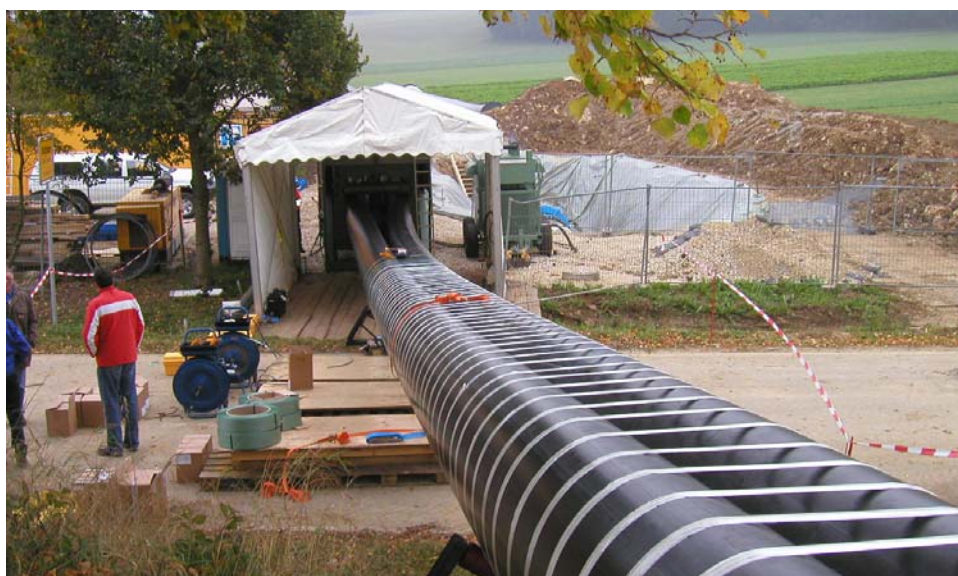
Bild 10: Mit Spannbändern versehener Inliner
