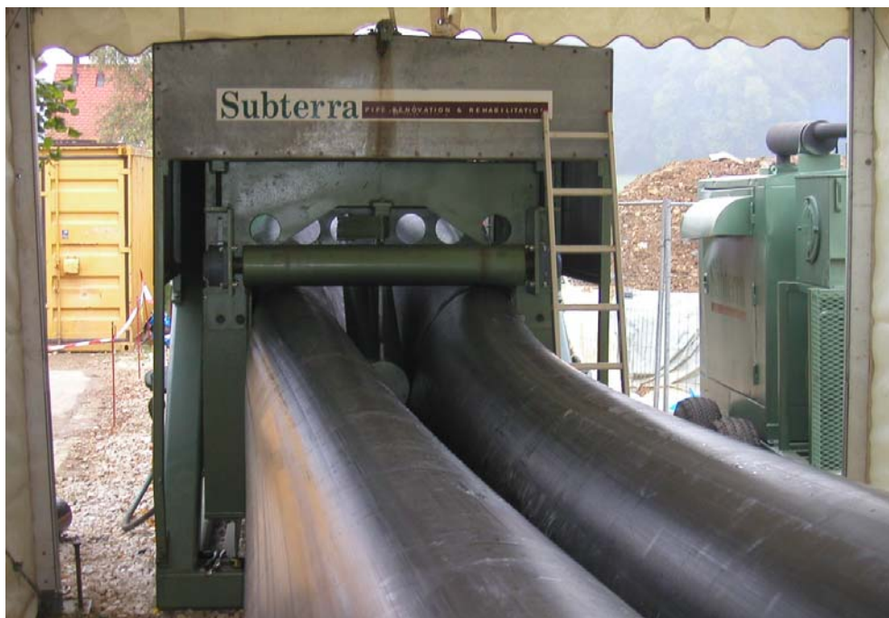
Bild 9: Verformen des PE-Rohres zum c-förmigen Inliner
